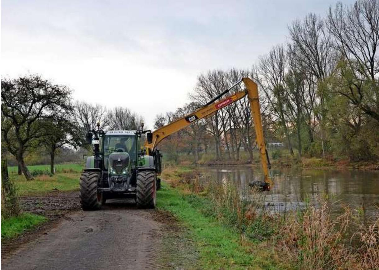
Mit einem Langarmbagger wurde Ende 2021 Schlamm aus dem Luther See entfernt.
